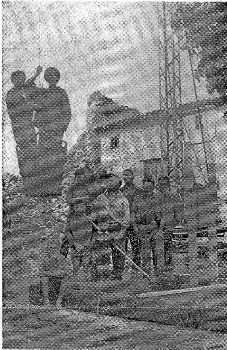
Ayant pris place dans le seau de maçon, MM. Sarda et Antonio Gimenez, tels des astronautes, sont élevés dans l'espace par le filin de la grue. Et ensuite, ce sera la descente dans le puits.
