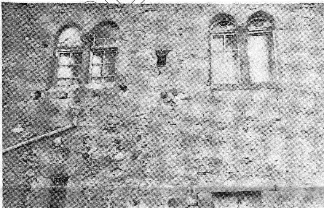
En dépit des transformations et multiples réparations, l'une des façades offre encore deux belles fenêtres géminées.
